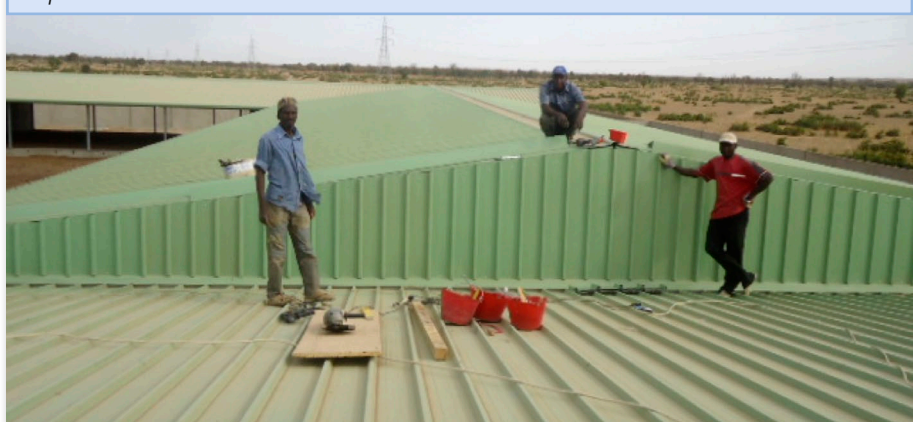
Operai al lavoro sul tetto della scuola
